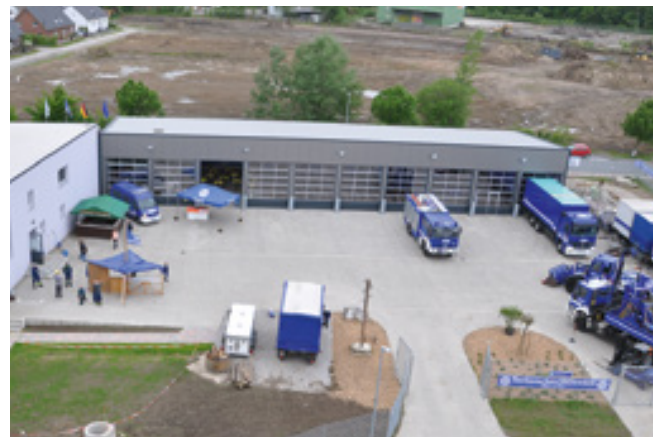
Das THW investiert in moderne Liegenschaften. Im Ortsverband Ronnenberg (Niedersachsen) wurde im Mai die erste THW-Unterkunft in Passivhausbauweise übergeben. | THW invests in modern real estate. In the local section of Ronnenberg (Lower Saxony), the first THW accommodation in passive house design was handed over in May.
